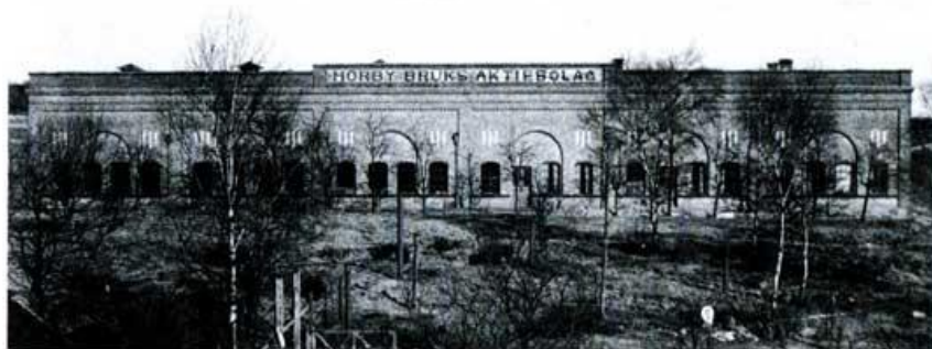
Fasaden sedan Eriksson inrett bostad och kontor i sydvästra hörnet av byggnaden.
