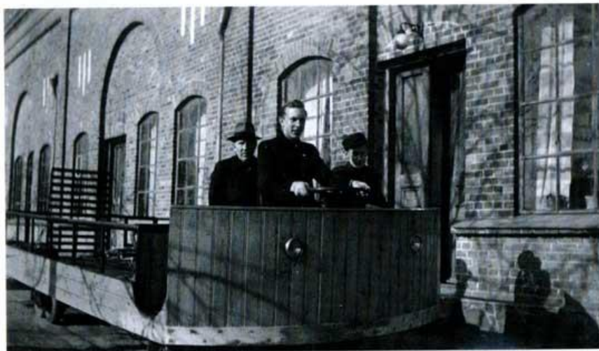
Det här egentillverkade elfordonet fick under krigsåren ersätta den lastbil som staten hade beslag på.
