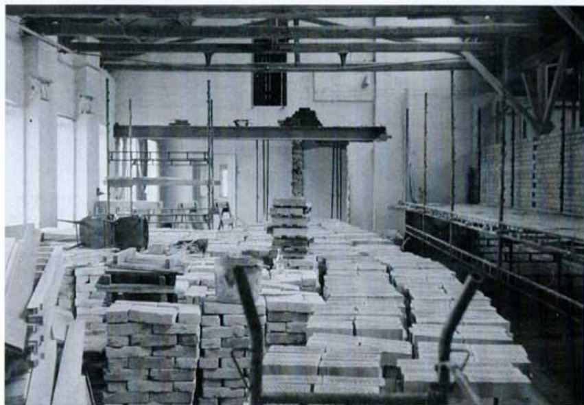
Utställningslokalen under arbete.
