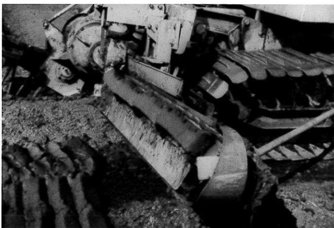
Utläggning av torv med Hyttfors kedjefräs, 1958. Foto i privat ägo.
