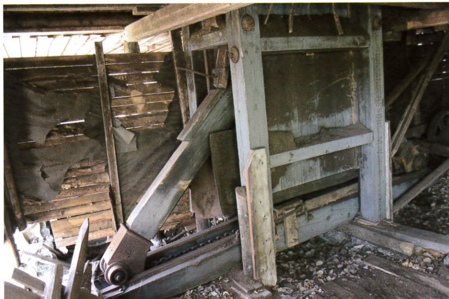
Torvströpress av fabrikt Äbjörn Andersson i Odenlanda södra torvfabrik.
