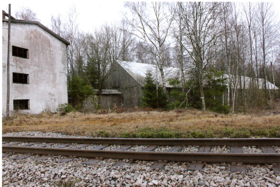
Fabrik i betong med torvlada, Strängnäs.
