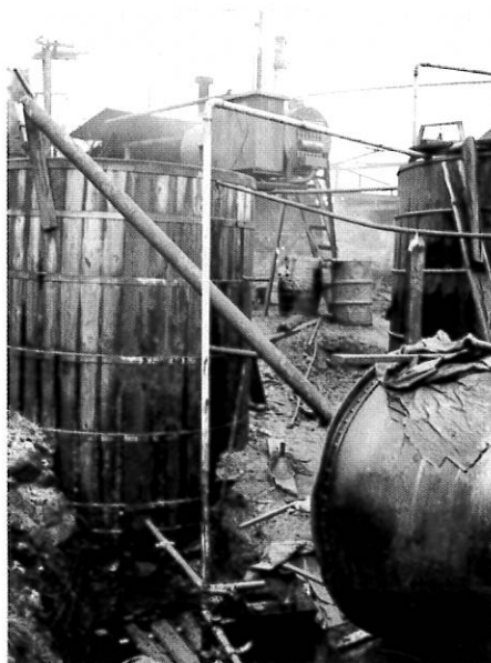
Tjärkaret i laggat utförande rymde 10 m 3 . Foto: Okänd. Tekniska museet.
