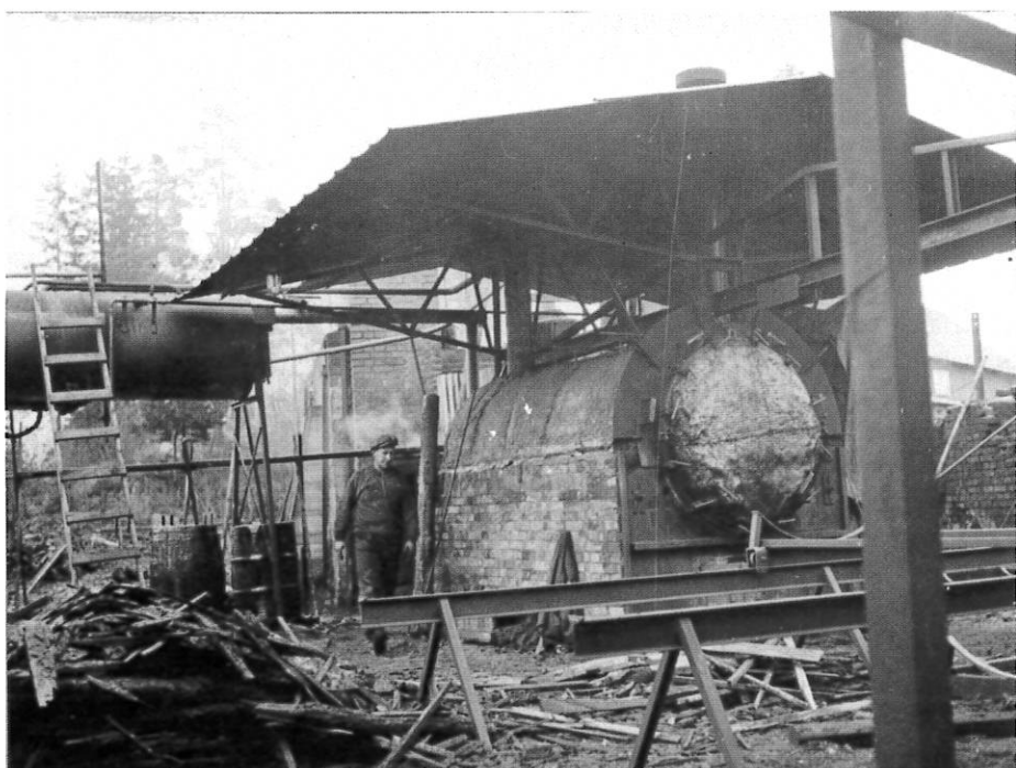
Tjärugnen matades från ena sidan genom ett hål som murades igen efter tändningen. Foto: Okänd. Tekniska museet.
