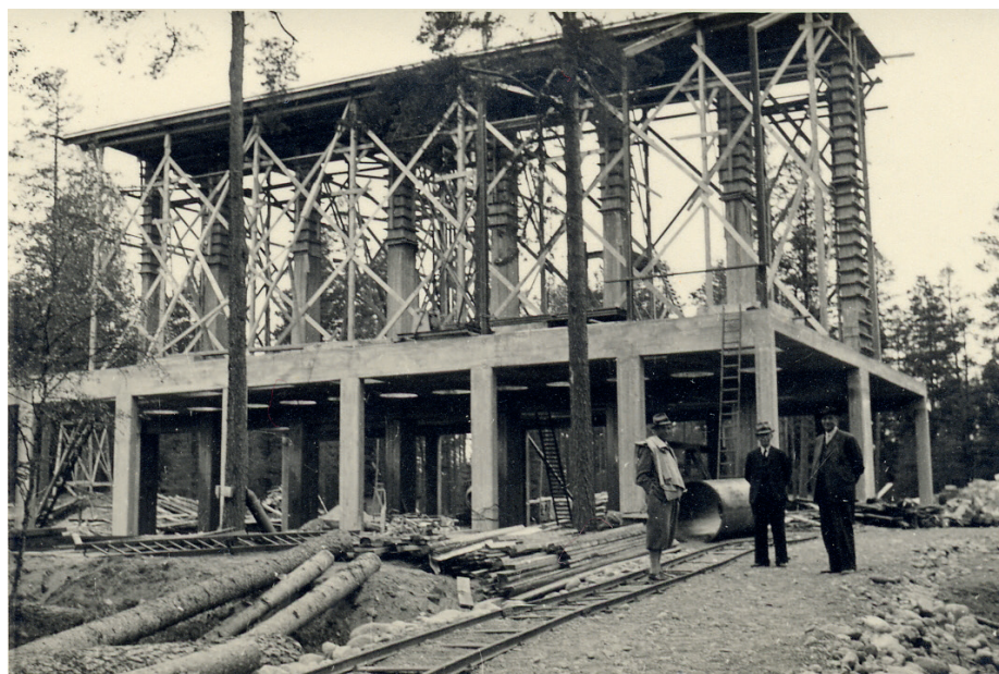
Stommen till torvkolsugnarna under uppförande. Det var delar av denna stomme som 30 år senare benämndes världens största äggställ. Eric Hyttfors arkiv.
