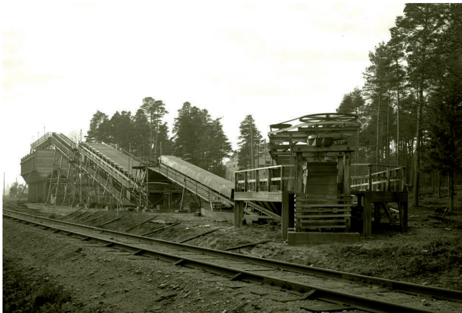
Linbanans vändstation. Här tömdes cylindrarna med torvkol i en transporttör med efterföljande kylramp. Från lastfickan längst till vänster i bild lastades torvkol i järnvägsvagnar. Foto: Hertzberg, Ljungby kommunarkiv.
