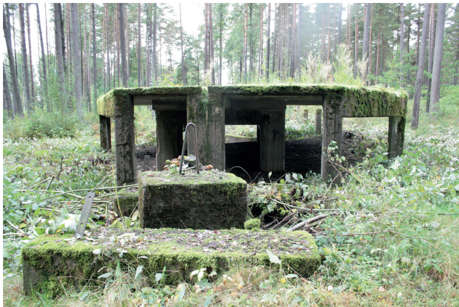
Utöver tre rader med betongplintar är detta vad som återstår av den stora torvkolsfabriken i nuvarande naturreservatet Kronoskogen i Ljungby. På bilden syns grunden till linbanans vändstation och bland annat linbanans motvikt. Jämför med det gamla fotot med järnvägen i förgrunden. Foto: Elisabet Johansson.
