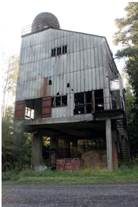
Utanför Vittsjö finns fortfarande, 2018, resterna efter torvkolsfabriken, som byggdes för 6 ugnar. Byggnaden är lika de övriga tre, men bara hälften så lång och hälften så bred som den i Ljungby. Lägga märke till observatoriet på taket. Foto: Elisabet Johansson.
