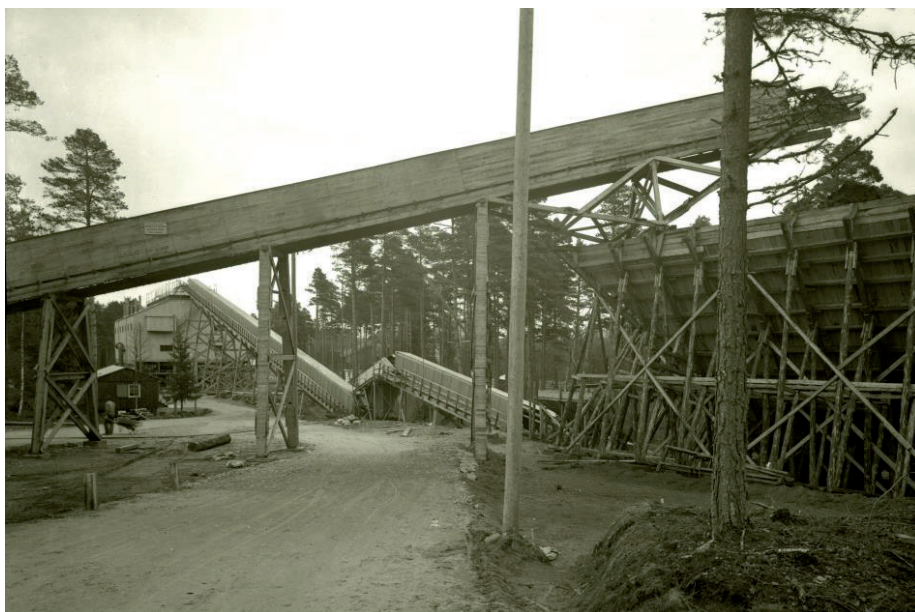
Torvkolningen pågick dygnet runt. Lastbilarna med torv tömde sin last i en ficka för användning direkt, eller också i fickan närmast i bild via en transportör, för att användas under natten. Foto: Hertzberg, Ljungby kommunarkiv.
