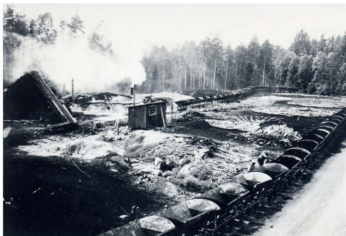
Kolningsplatsen vid Förarps mosse 1957 med milbottnar, mila under uppbyggnad, tända milor, kolarkojan i mitten och en mängd torvvagnar.
