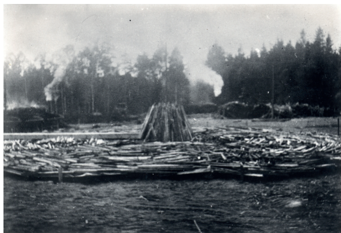
Milans botten med tändkanal och början till skorsten i mitten.
