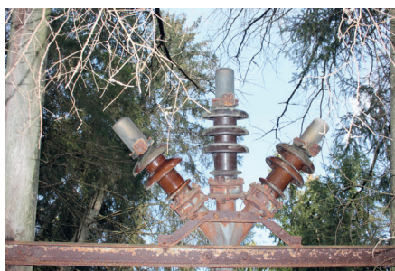
Ett kraftkontrakt med Sydkraft sades upp 1958, men ännu finns isolatorer kvar vid transforma-torbyggnaden.
