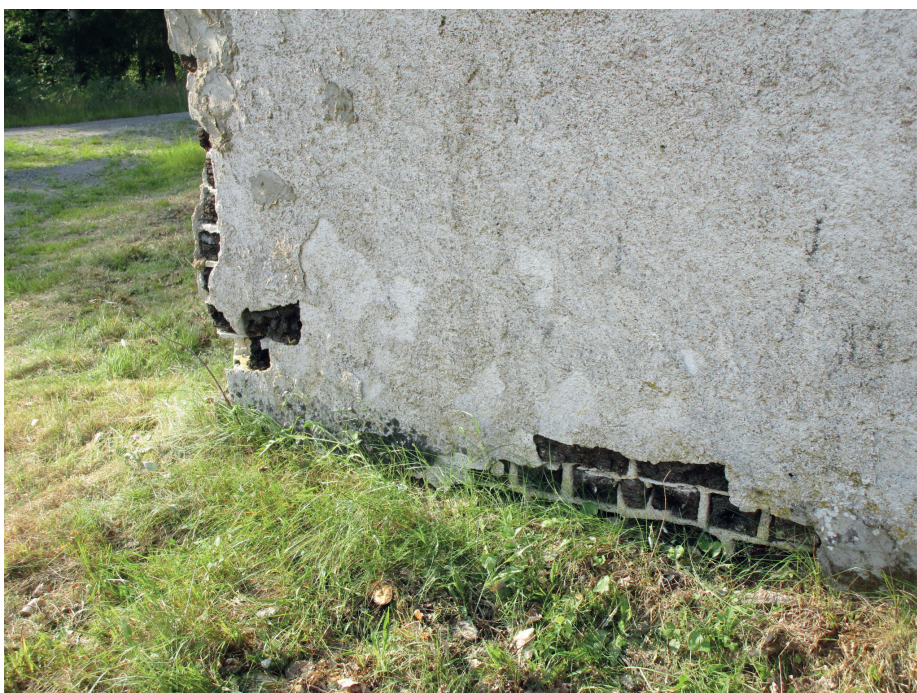
Här syns den ruffliga ytan på väggen och de raka fogarna mellan "torvtegel".
