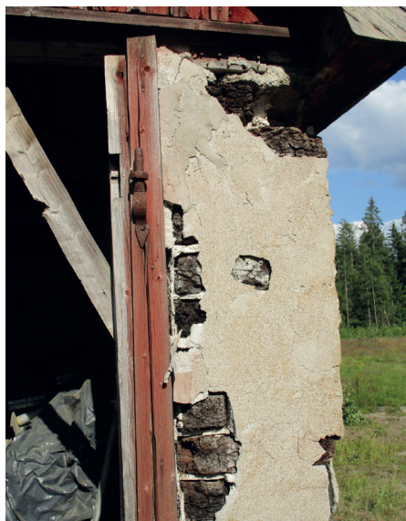
Lokstallets frontsida har varit täckt av kraftiga dörrar. Endast dörrkarmen med sina gångjärnsfästen syns idag.
